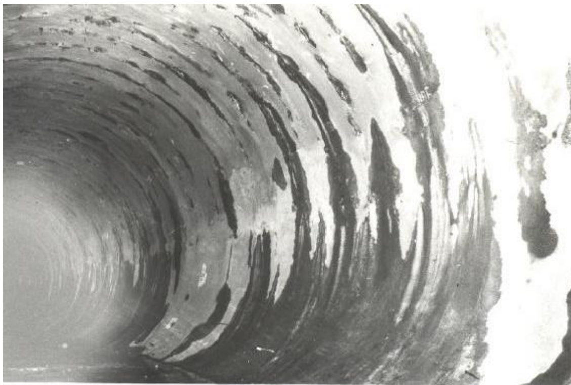
Figura 31 - Túnel executado em NATM com elevado nível de vazamentos. Fonte: FIGUEIREDO, 2005
