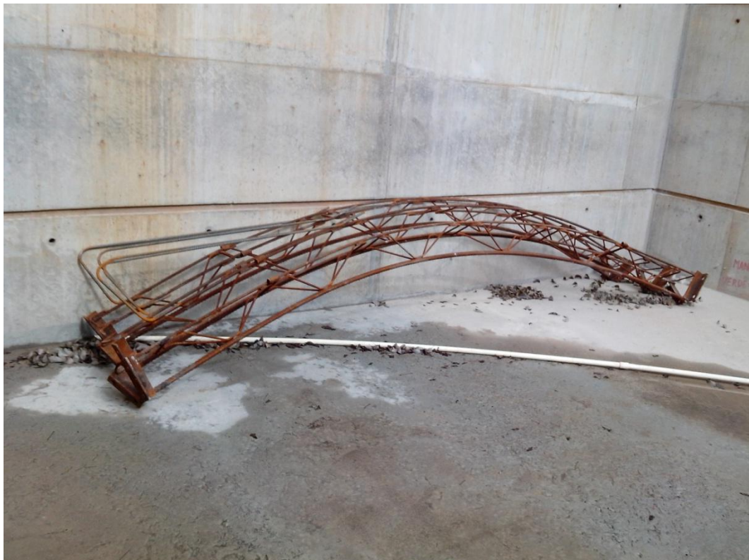
Figura 40- Cambota metálica. Foto tirada em 25 de Julho de 2014, durante visita técnica as obras da linha 5 do metrô .
