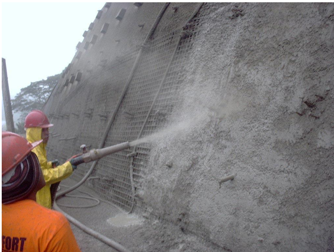
Figura 17 - Formação de poeira no bico de projeção. Fonte: FURLAN ENGENHARIA E ARQUITETURA
