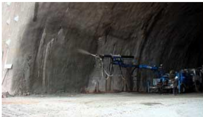
Figura 8 - Robô de projeção com alimentador de fibras integrado à central de concreto. Fonte: BASF - Rodoanel Metropolitano Mário Covas (www.basf-cc.com.br)
