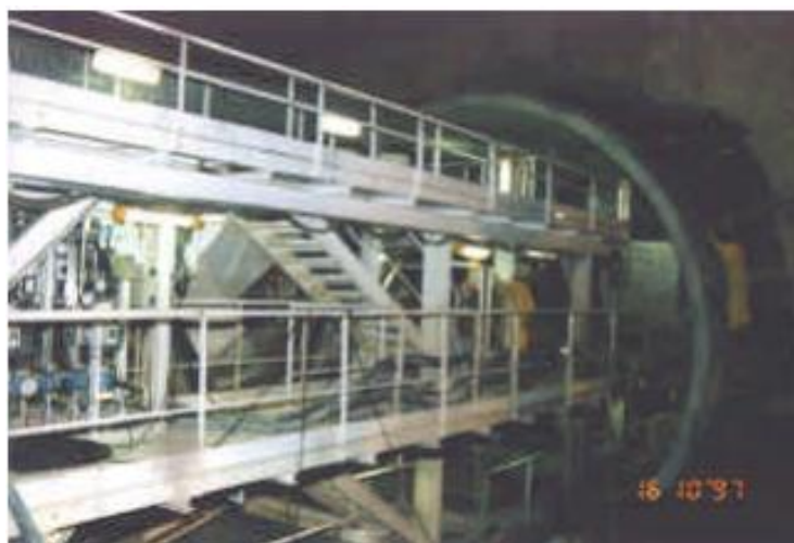
Figura 35 - Shield com suporte mecânico frontal Fonte: Metrô de Madrid
