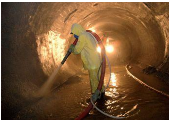
Figura 7 - Projeção no interceptor do Rio Pinheiros (IPI-6), em São Paulo, executado pelo consórcio composto pela Telar Engenharia, Grupo Tejoflan e Augusto Veloso
